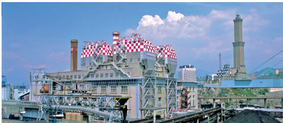
Una prospettiva della Centrale ENEL nel porto di Genova, non più in produzione (ph Corporate Enel)
